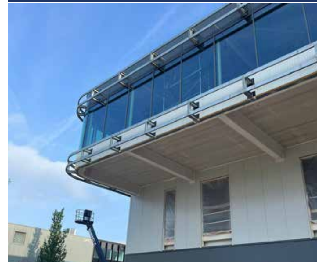
Ons nieuwe hoofdkantoor in aanbouw
