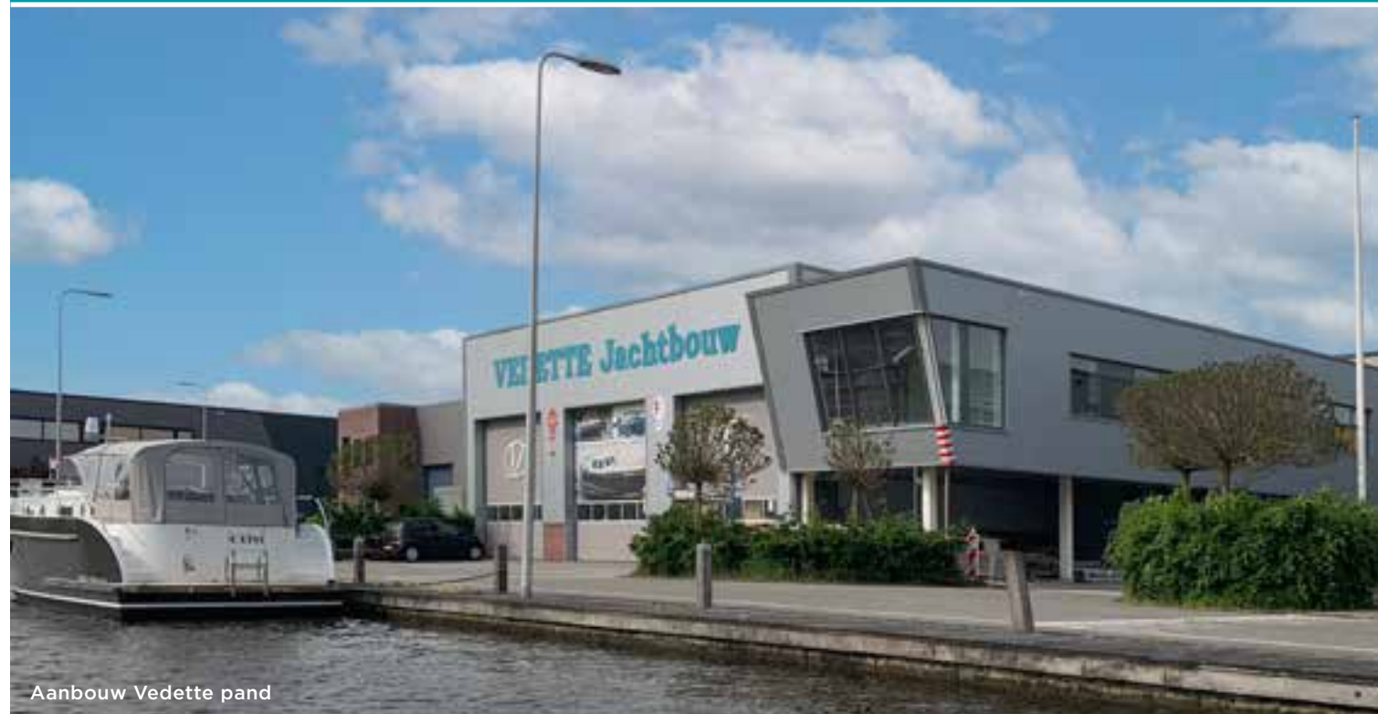
Aanbouw Vedette pand
